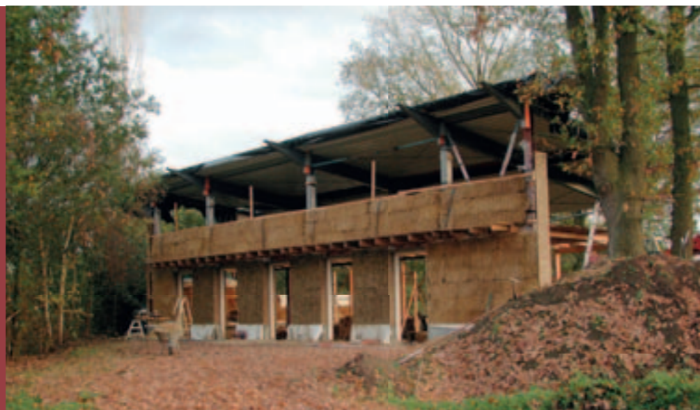
Noordgevel van het strobalen huis in aanbouw
