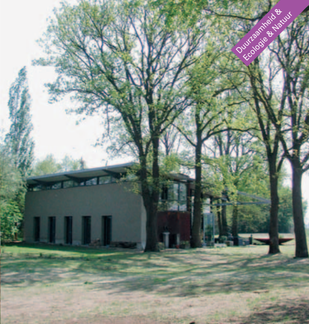
Noordgevel van het strobalen huis afgebouwd
